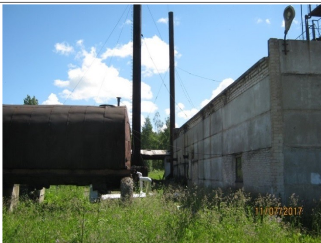
Рисунок 1.2.1. – Здание и баки котельной № 1
